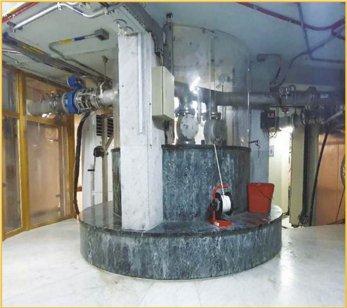
Le puits de ZamZam dans sa forme actuelle, situé sous la zone de Mataf, entouré d'une barrière en béton recouverte de marbre vert.
