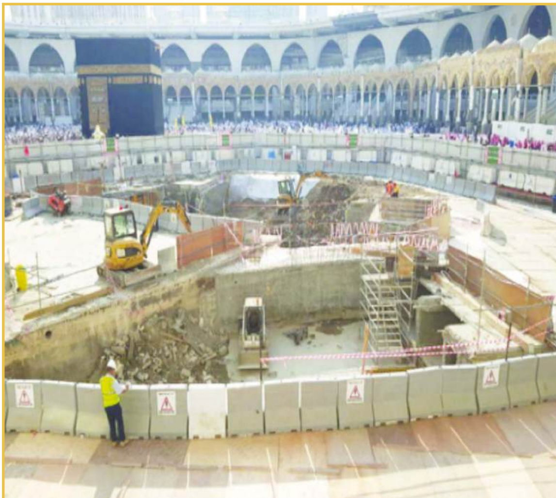
Une image du « projet de réhabilitation du puits ZamZam » montrant le mécanisme de nettoyage du puits, l'agrandissement de la zone de la source et l'amélioration du système d'approvisionnement et de distribution en eau.
