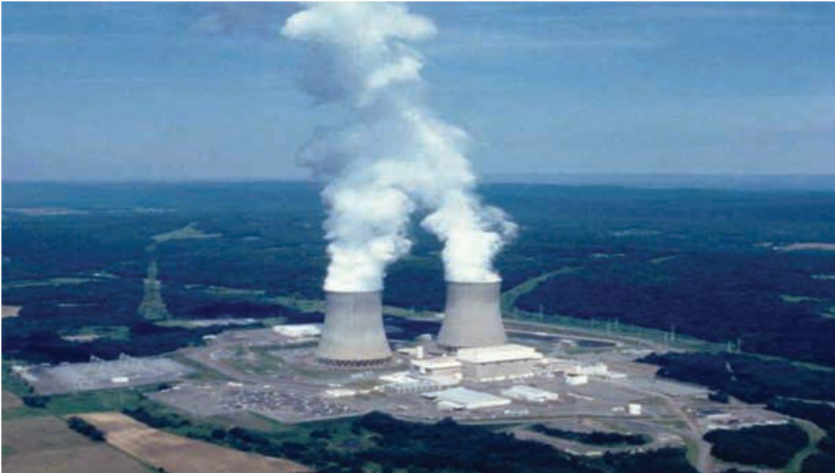
محطة سسكويهانا للكهرباء البخارية، مفاعل الماء المغلي. وتقع المفاعلات داخل مباني الاحتواء المستطيلة باتجاه مقدمة أبراج التبريد (Stonge, 2011)
