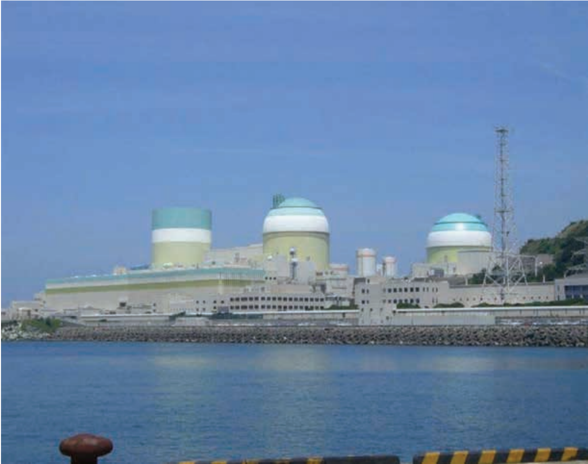
محطة إيكاتا للطاقة النووية، عبارة عن مفاعل ماء مضغوط يتم تبريده عن طريق تبادل المبرد الثانوي مع المحيط (Stonge, 2011).
