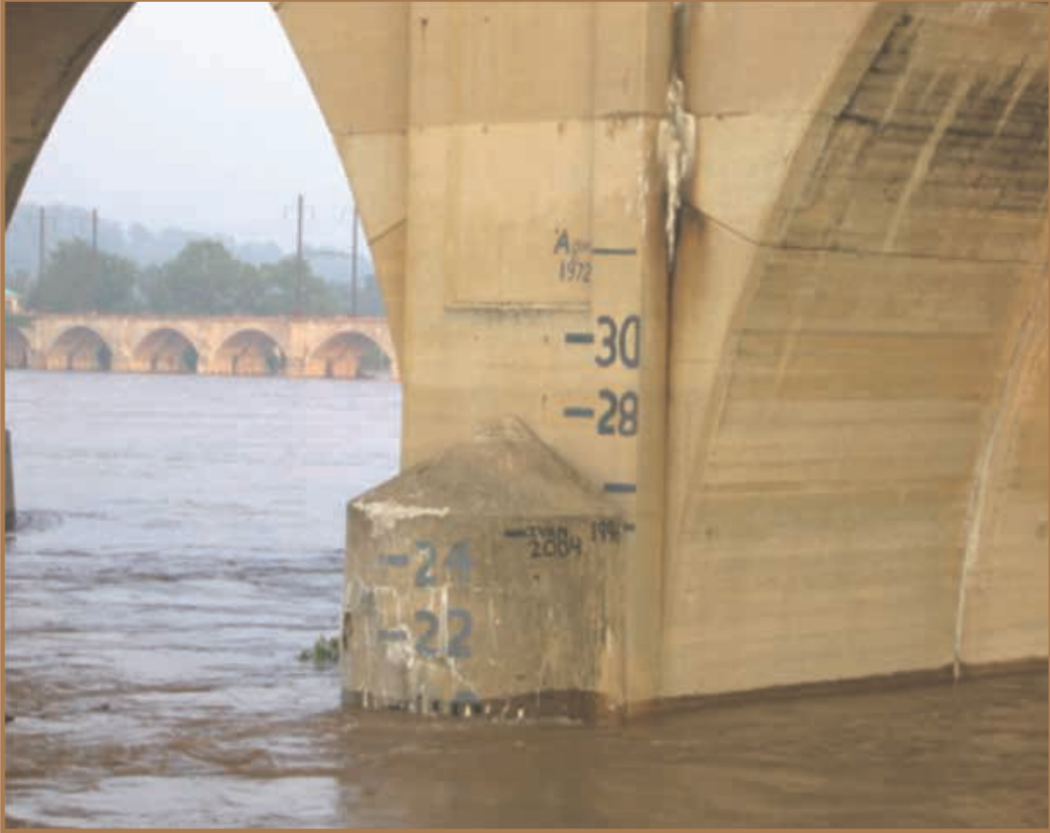
مقياس مدرج لارتفاع الماء في القناة النهرية
