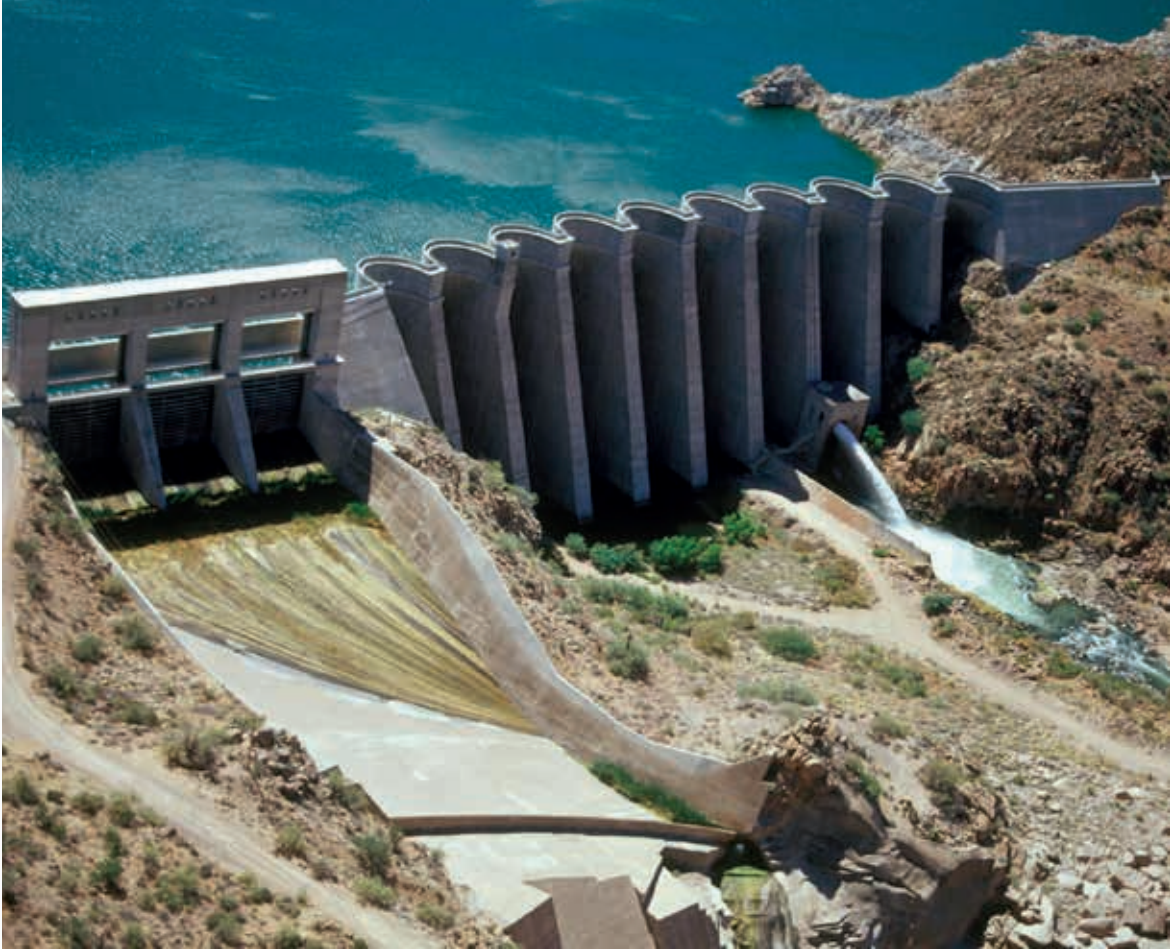
يبلغ طول سد بارتليت متعدد الأقواس الواقع على نهر فيردي في ولاية أريزونا (244 م) وله 10 أقواس وليس قوساً واحداً.
