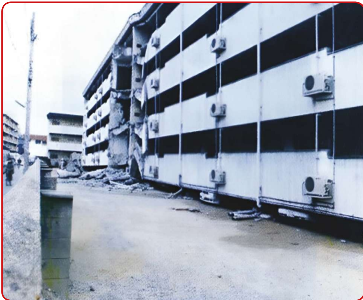
إنهيار كامل للدور الأرضي لضعف مقاومته للقوى الجانبية
