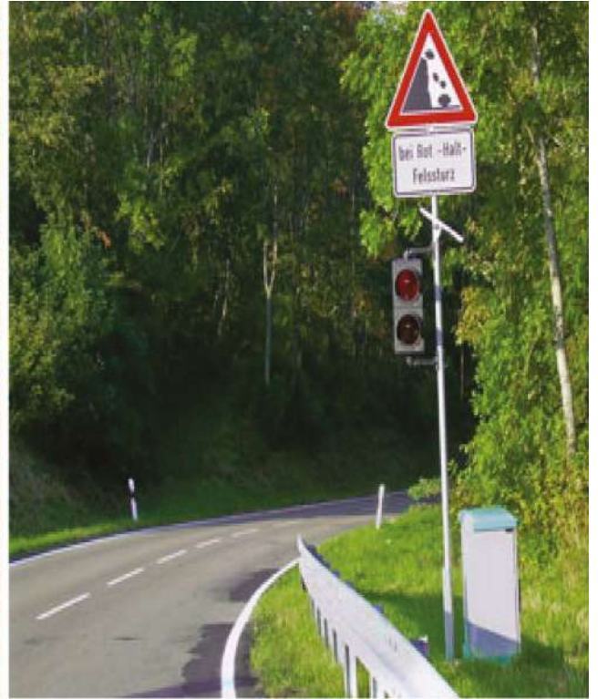
نظام الإنذار المبكر في انهيار أرضي وينكلغرات Winkelgrat مجهز بمقاييس تمدد أوتوماتيكية (يسار) وإشارة مرور لإغلاق الطريق (يمين).
