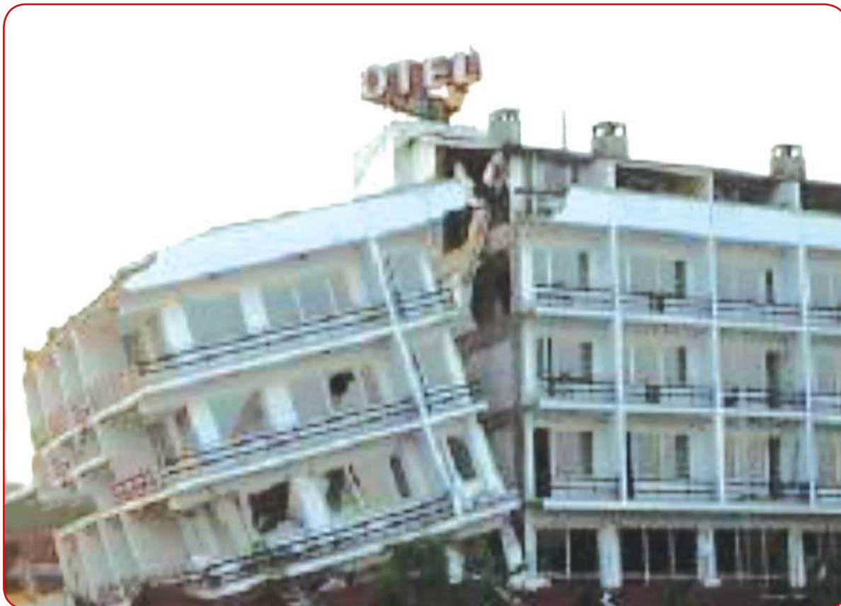
انهيارات في المباني بسبب ظاهرت تشكيل الطابق الرخو في الطابق الأرضي
