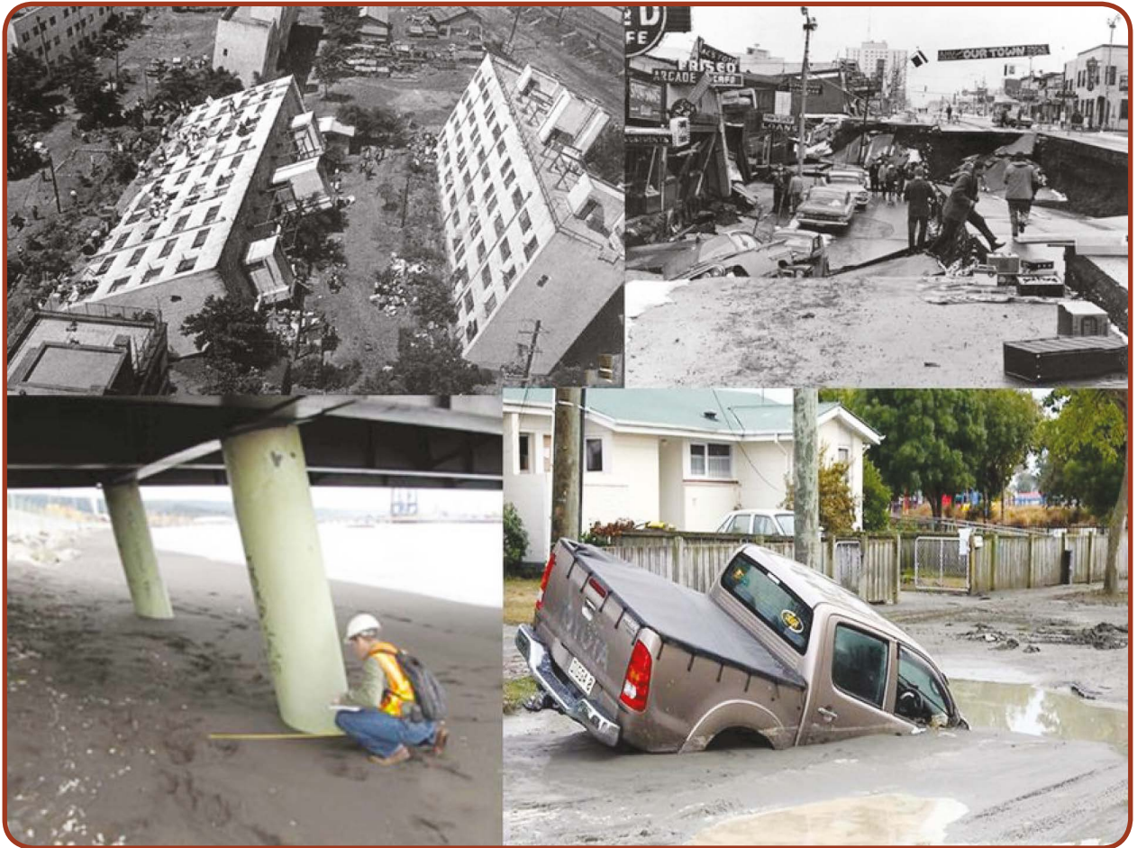
الضرر الناجم عن التسييل لوحظ في (أ) نيجاتا ، اليابان 1964 (ب) ألاسكا ، الولايات المتحدة الأمريكية 1964 (ج) مولي ، تشيلي 2010 و (د) كرايستشيرش ، نيوزيلندا 2010
