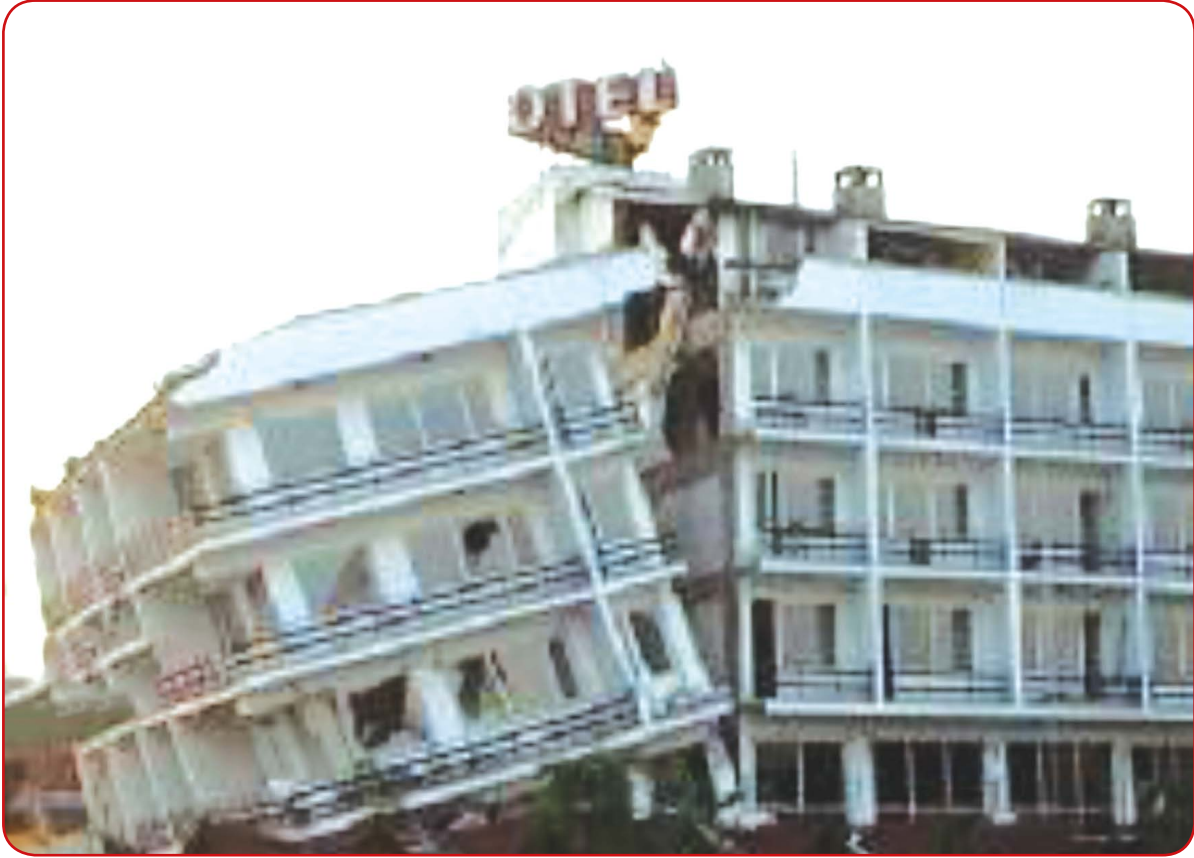
انهيارات في المباني بسبب ظاهرة تشكيل الطابق الرخو في الطابق الأرضي
