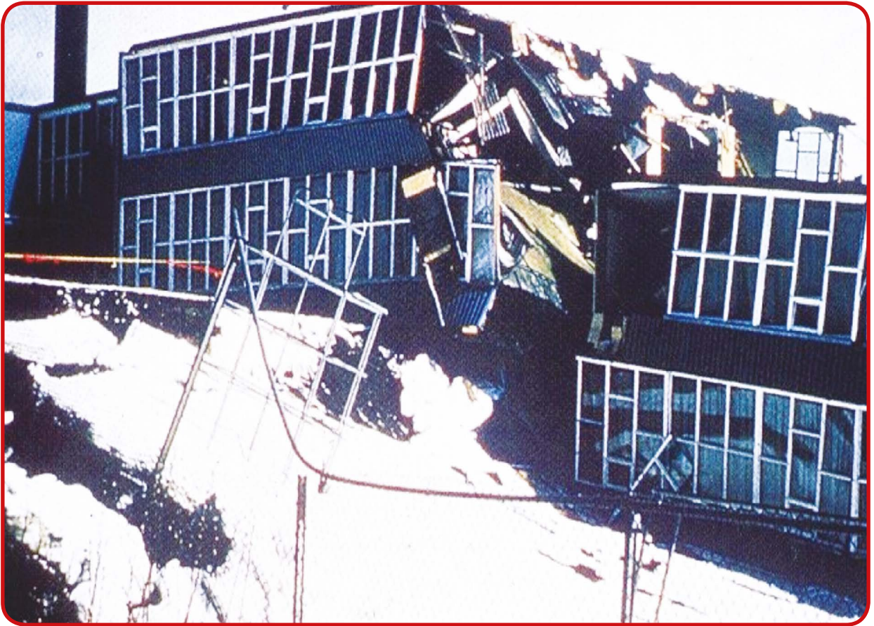
انشطار مبنى مدرسي بسبب انزلاق ارضي أحدثه زلزال الاسكا عام 4691 م
