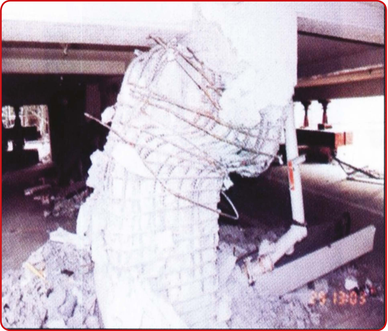
إنهيار رقبة عمود بسبب قوى القص
