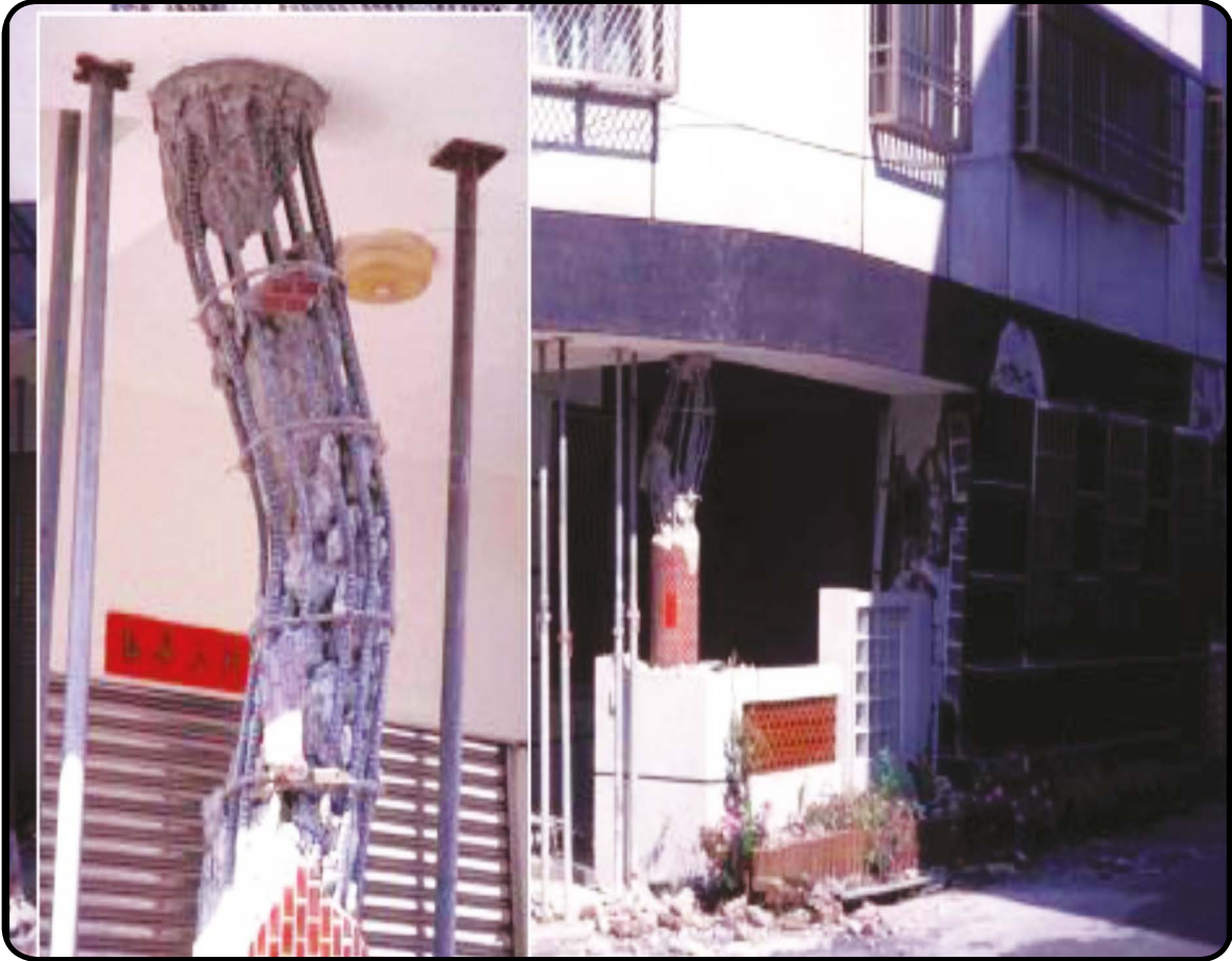
فشل القص الهش للأعمدة الداعمة
