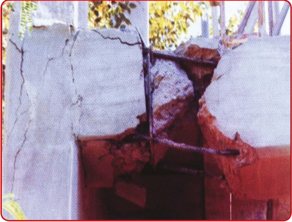
أضرار بالغة لككرة خرسانية بسبب تقييد حركتها بسلم حديد مثبت عليها
