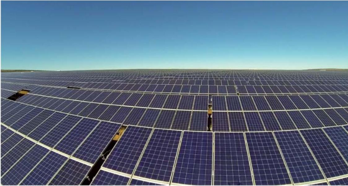
مشروع جاسبر للطاقة الشمسية الكهروضوئية **Jasper Solar PV Power Project**، في جنوب إفريقيا. يتكون مشروع جاسبر من 325000 لوح شمسي بسعة 96 ميغاواط. دخل المصنع الخدمة في أكتوبر 2014 وهو حالياً الأكبر في إفريقيا. اعتباراً من عام 2016، تبلغ قدرة أكبر محطة للطاقة الشمسية في جميع أنحاء العالم 648 ميغاواط وتقع في كاموثي، تاميل نادو، الهند.
