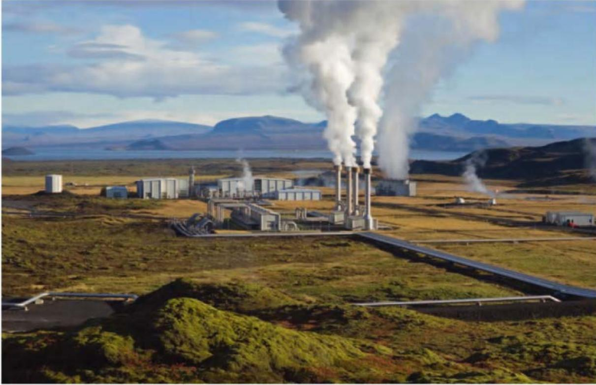
محطة نيسجافلير Nesjavellir لتوليد الطاقة في أيسلندا؛ تعطي 120 ميغاواط من الطاقة الكهربائية بالإضافة إلى 380 ميغاواط من الطاقة الحرارية من 83 درجة مئوية من المياه في عام 2010، وتصل درجات حرارة الخزان إلى 380 درجة مئوية.
