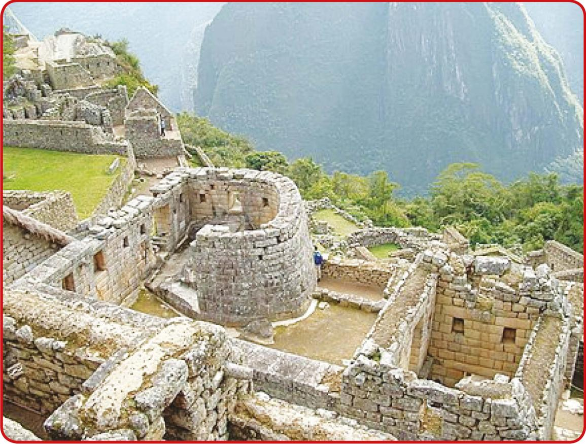
أثبت البناء بالحجر الجاف أنه أكثر مقاومة للزلازل من استخدام الملاط. يمكن أن تتحرك أحجار الجدران الحجرية الجافة قليلاً وتعيد الاستقرار دون انهيار الجدران ، وهي تقنية تحكم هيكلية سلبية تستخدم مبدأ تبديد الطاقة ومبدأ قمع التضخمات الرنانة .
