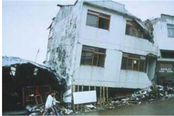
انهيار ناتج عن اختلاف مناسيب التأسيس
