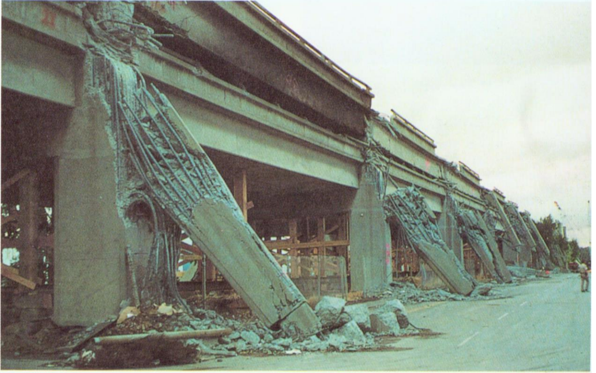
لم يستطع الجسر مقاومة الاجهادات الزلزالية عند منسوب الأساسات نجم عن ذلك انهيار قصي عند نقطة الاتصال بين الطابقين (زلزال لوما بريتا 1989).
