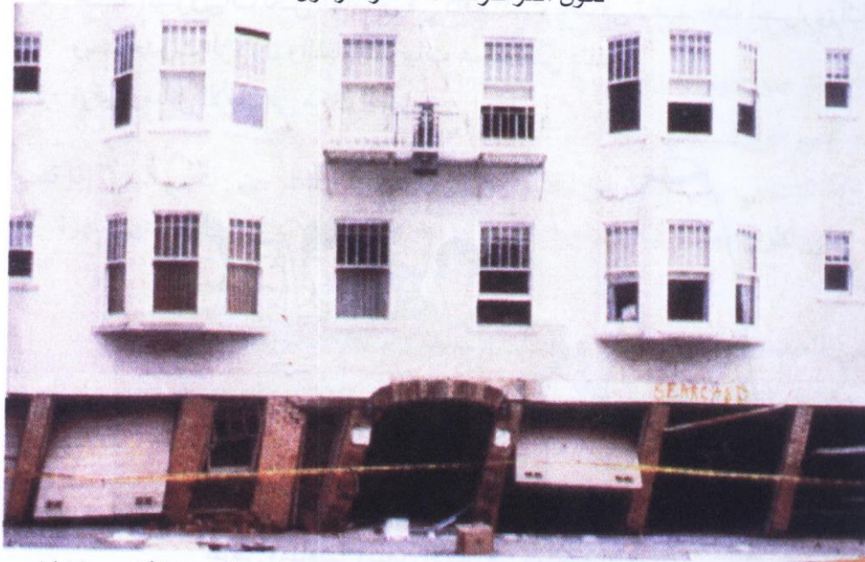
انهيار جزئي في الطابق الاول الهش نتيجة زلزال «لوما بيريتيا - كاليفورنيا أكتوبر ١٩٨٩»
