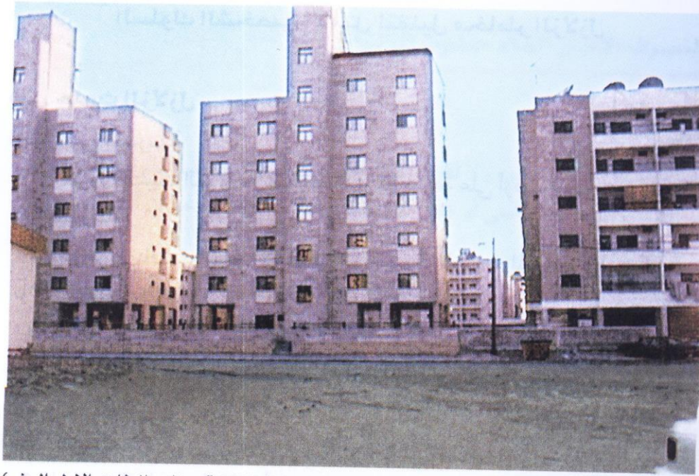
المنشآت التي يتكون فيها الطابق الارضي من الاعمدة فقط (المنشآت ذات الطابق الاول الهش) تكون اكثر عرضة لمخاطر الزلازل
