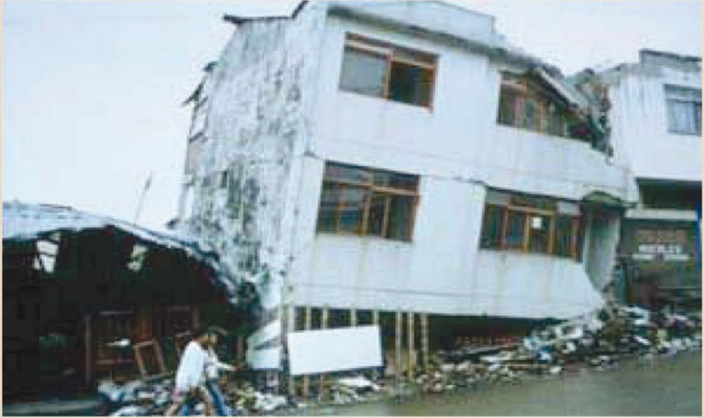
انهيار ناتج عن اختلاف مناسيب التأسيس
