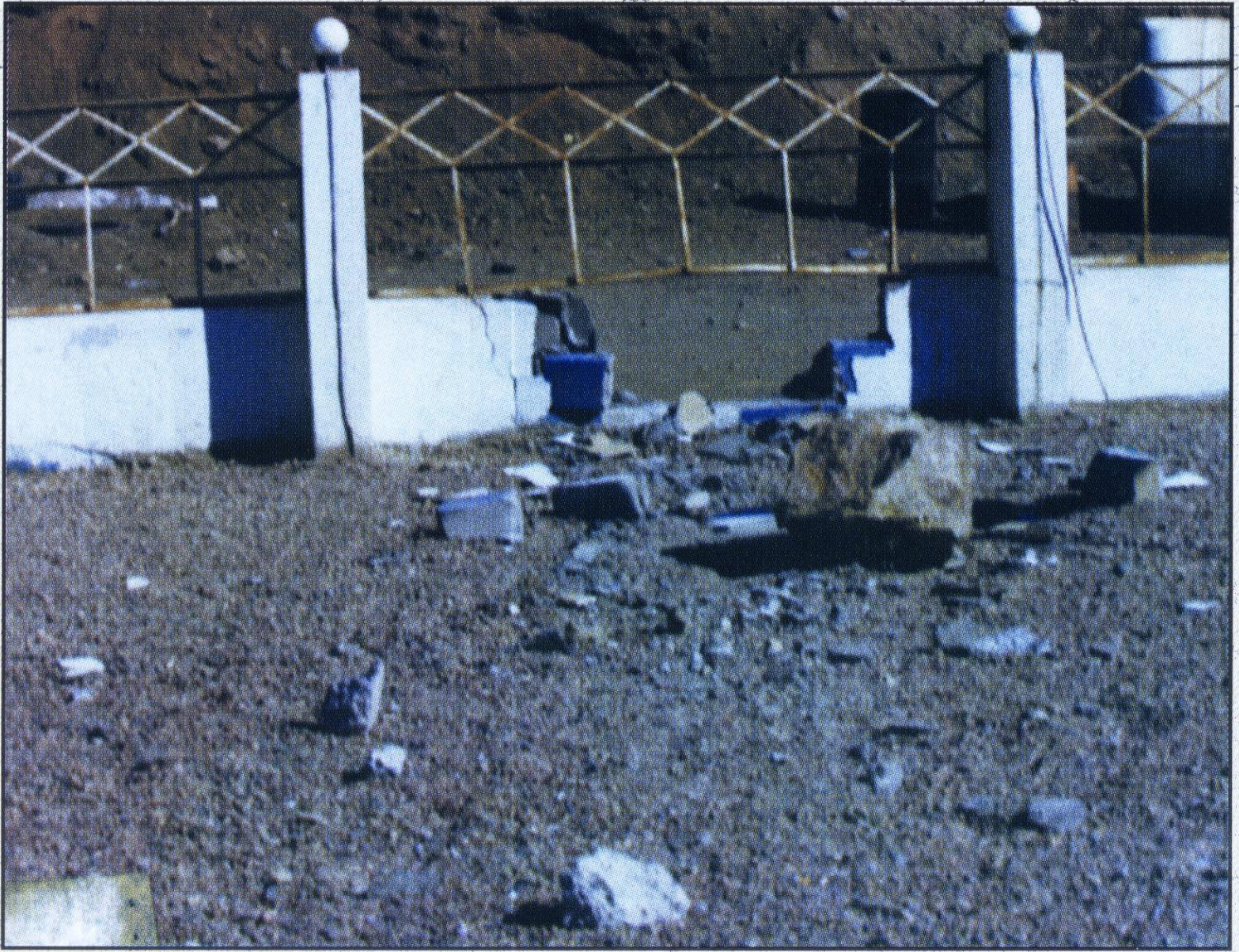
* شكل (١٤) تهم سور خرساني بسبب تساقط الصخور أثناء زلزال خليج العقبة ١٩٩٥ م.
