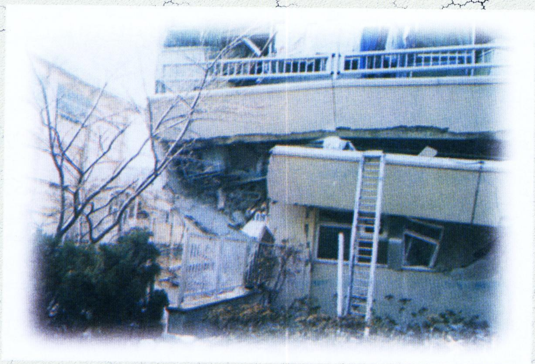
* شكل (٦) انهيار أحد الأدوار حيث كان يحتوي على حوائط أقل من الأدوار الأخرى .
