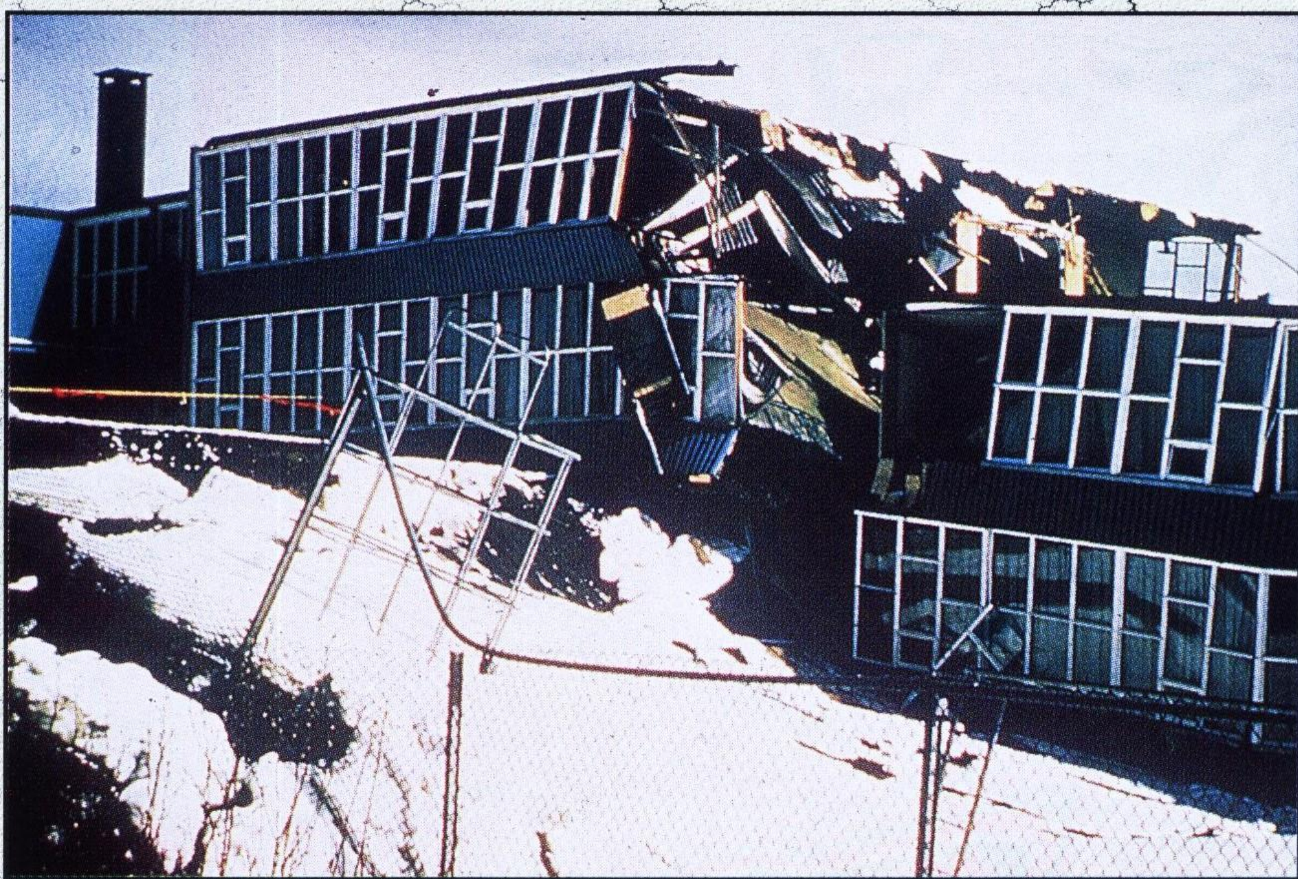
شکل (15) انشطار مبنی مدرسی بسبب انزلاق ارضی احدثه زلزال الاسکا عام 1964م
