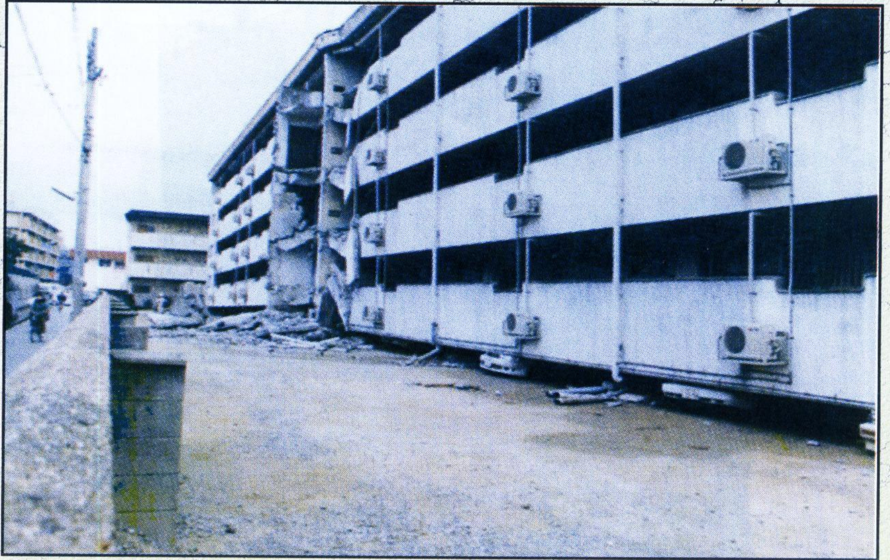
* شكل (٥) إنهيار كامل للدور الأرضي لضعف مقاومته للقوى الجانبية.
