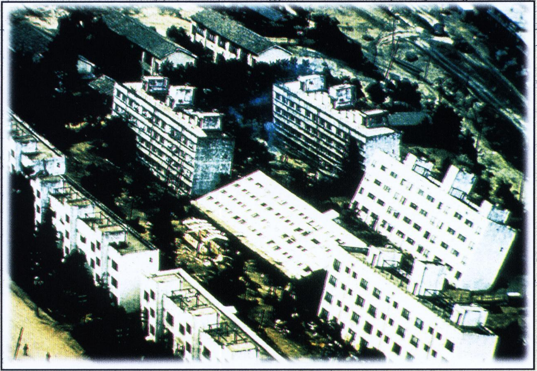
* شكل (١٧) إنقلاب لمبنى بسبب تميع التربة أثناء زلزال تيجاتا ١٩٦٤ م.
