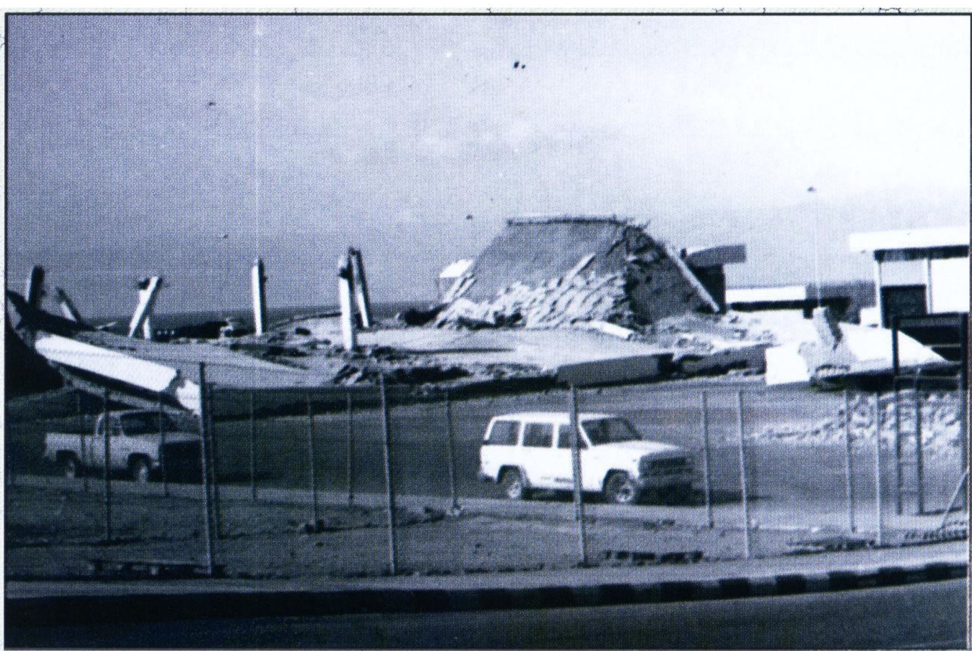
* شكل (١) إنهيار كامل لمظلات صالات خرسانية أثناء زلزال خليج العقبة ١٩٩٥ م.
