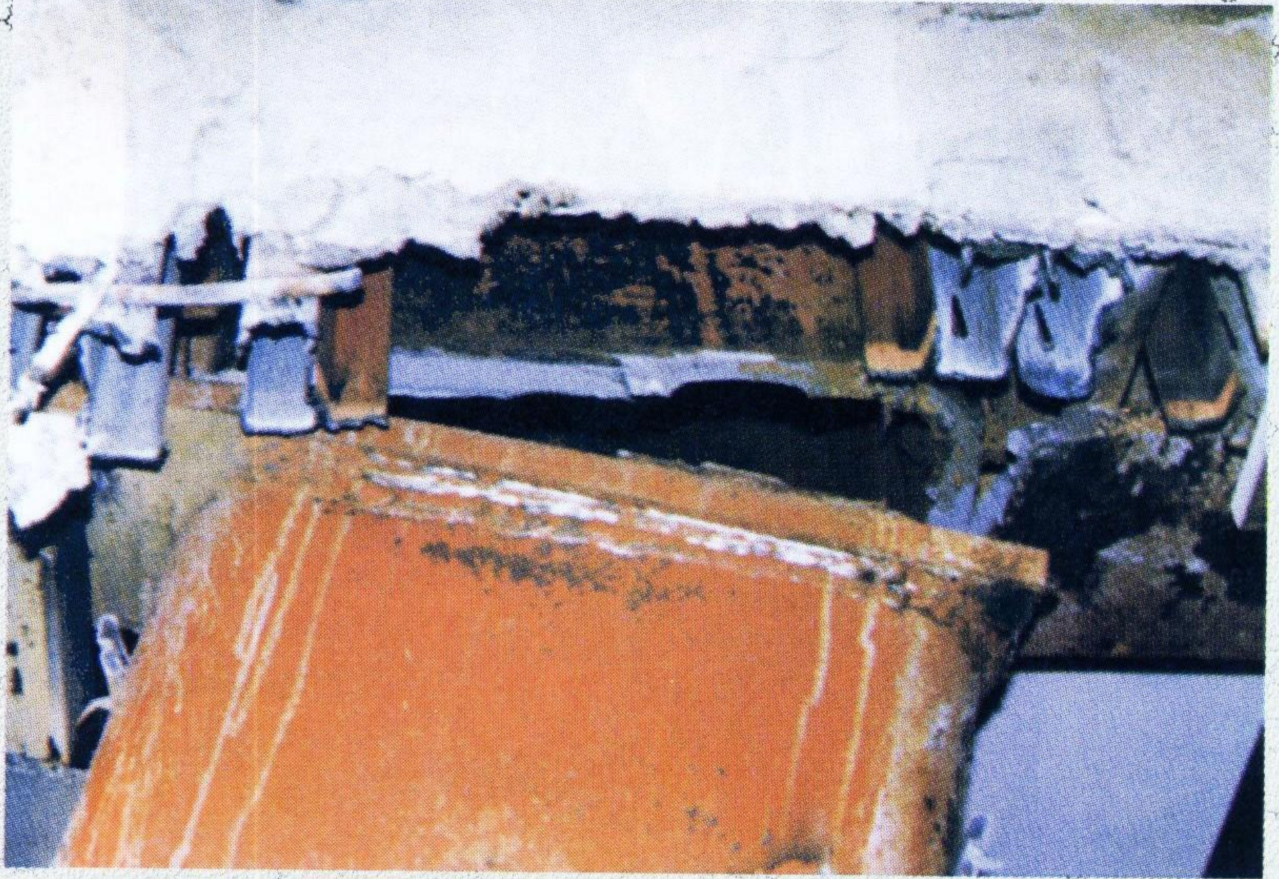
* شكل (١٢) تهشم لوصلات اللحام بسبب الزلازل .
