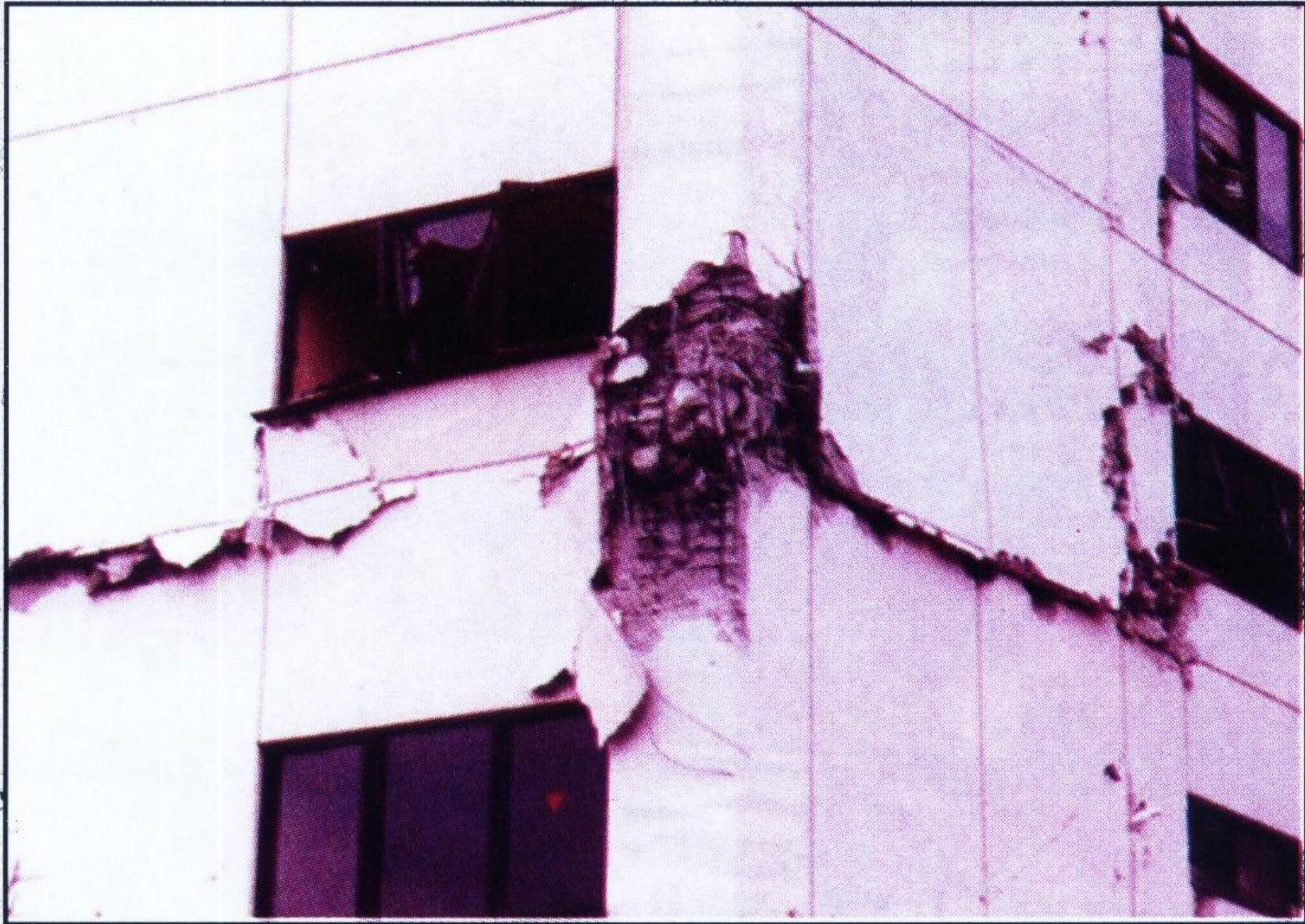
اضرار انشائية عند الحد الفاصل بين نظامين انشائيين مختلفين
